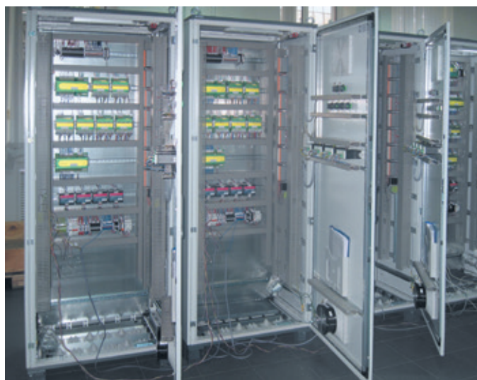
Рис. 3. Шкафы автоматики на полигоне НПФ “КРУГ”
